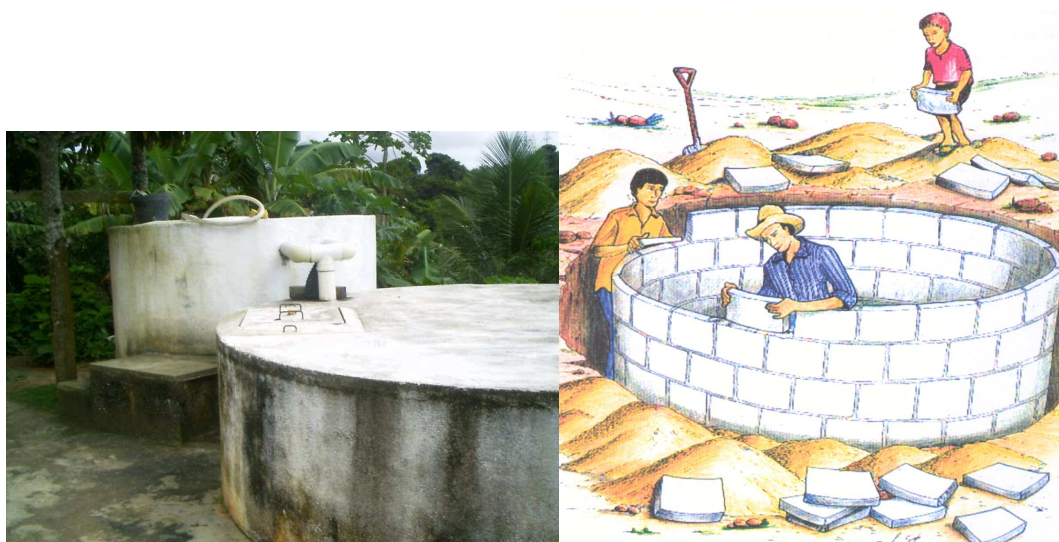
Photo 8 : Une citerne de plaque et sa construction
