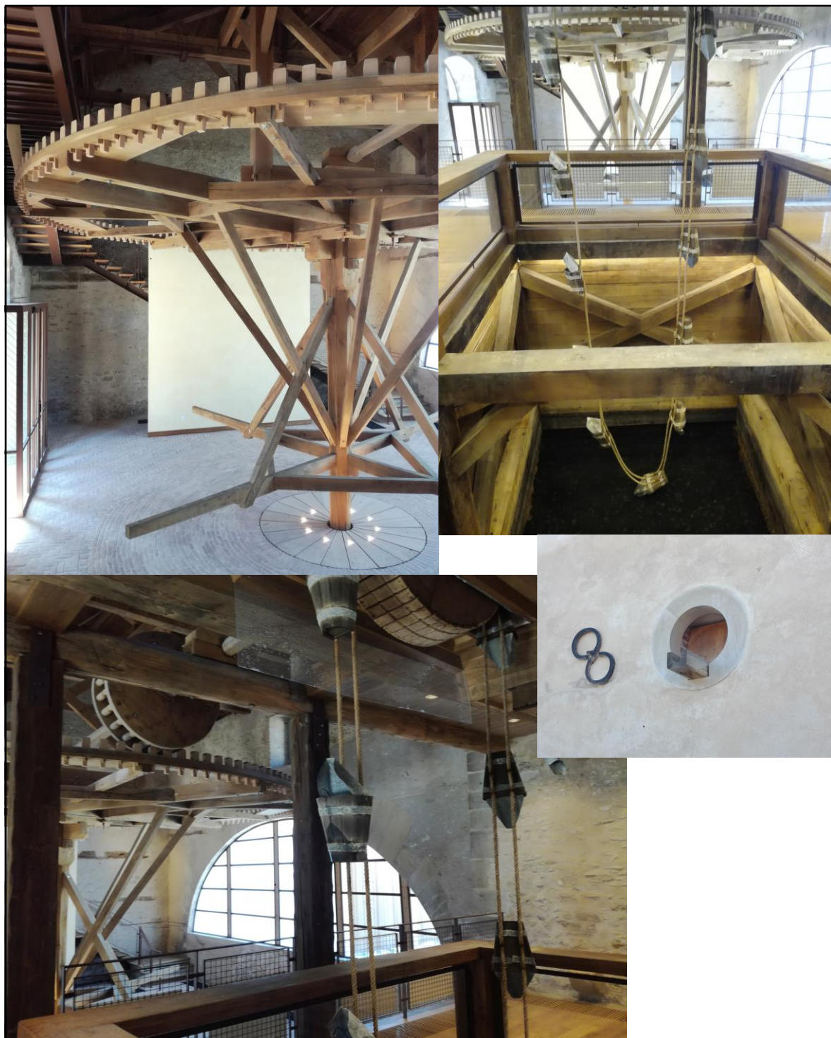
Fig. 27 : Photographie du manège et du puits salée de la saline de Dieuze
