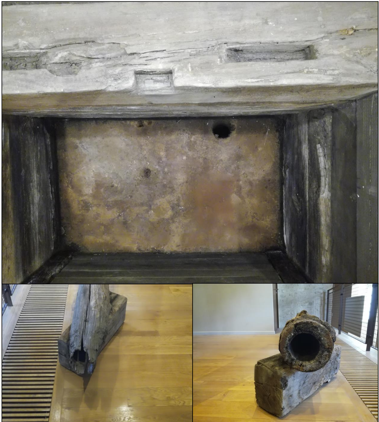
Fig. 32 : Photographie du départ du saumoduc de Dieuze et de la conduite en bois
