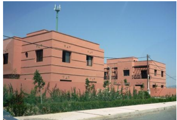
Maisons dans une résidence fermée parfois appelées par les promoteurs : « villas » ou « villas-eco » (Tamansourt, 2010).
