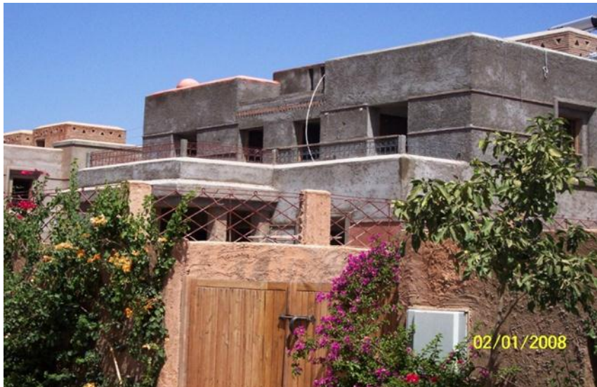
Photo 55 Maisons semi-finies bâties et vendues par Al Omrane Marrakech et finies par les habitants
