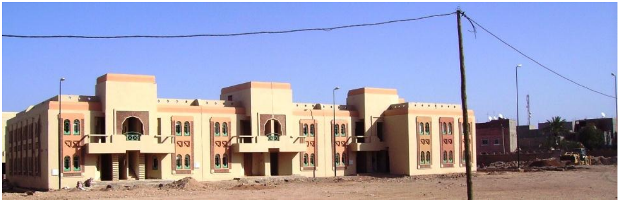
Photo 24 Quelques éléments physiques de mise en valeur des résidences fermées
