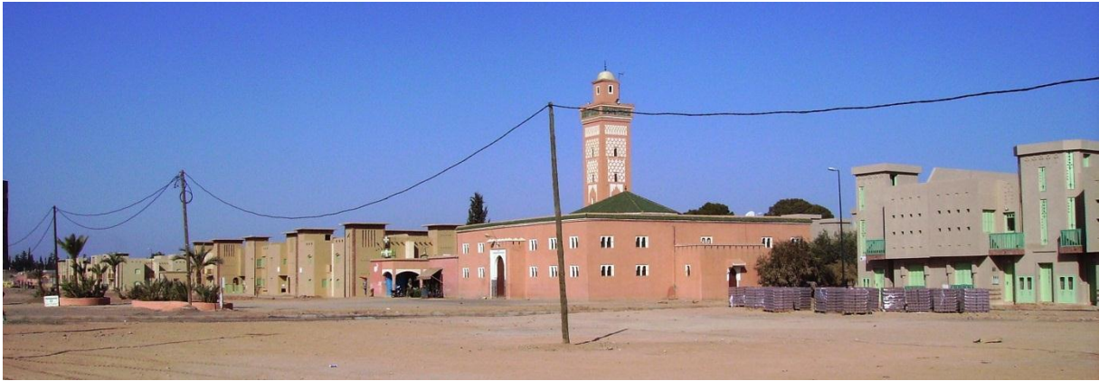
Le premier petit marché est situé au pied de la mosquée, entre deux résidences de villas-éco.
