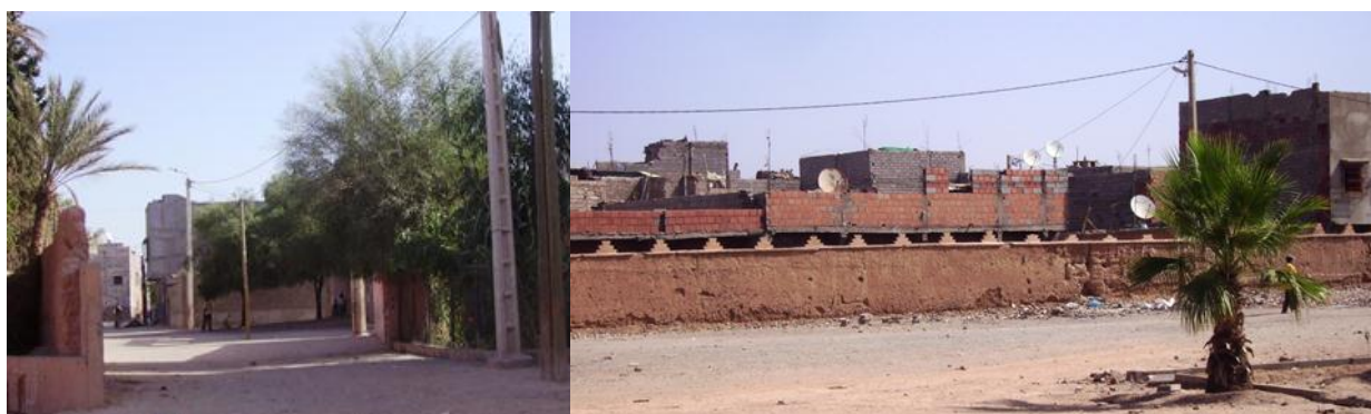
Photo 20 Une ruelle de Douar Tounsi et élévation d'étage à Douar Boun
