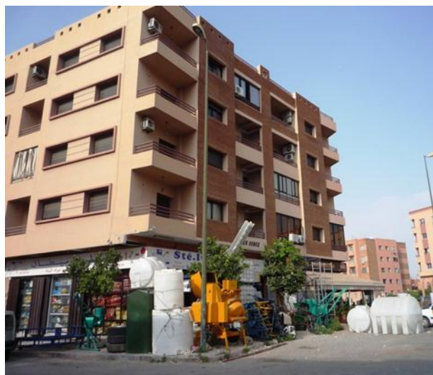
Une quincaillerie dans un espace commercial d'un immeuble (2009).
