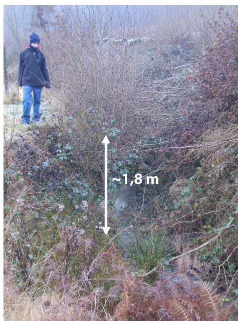
Figure 6.7 : forte incision locale du chenal à l'extrême amont du secteur A en conséquence probable des reboisements récents
