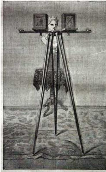
Figure III-4 Deux caméras utilisées pour la prise de vue en stéréoscopie « musée des sciences 1860 » (Musée des sciences s.d.)
