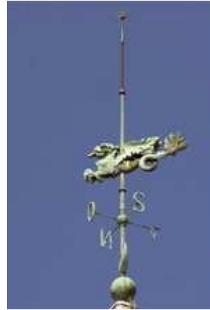
Figure 209 : La flèche du beffroi (Photo: Stéphane Compoint)
