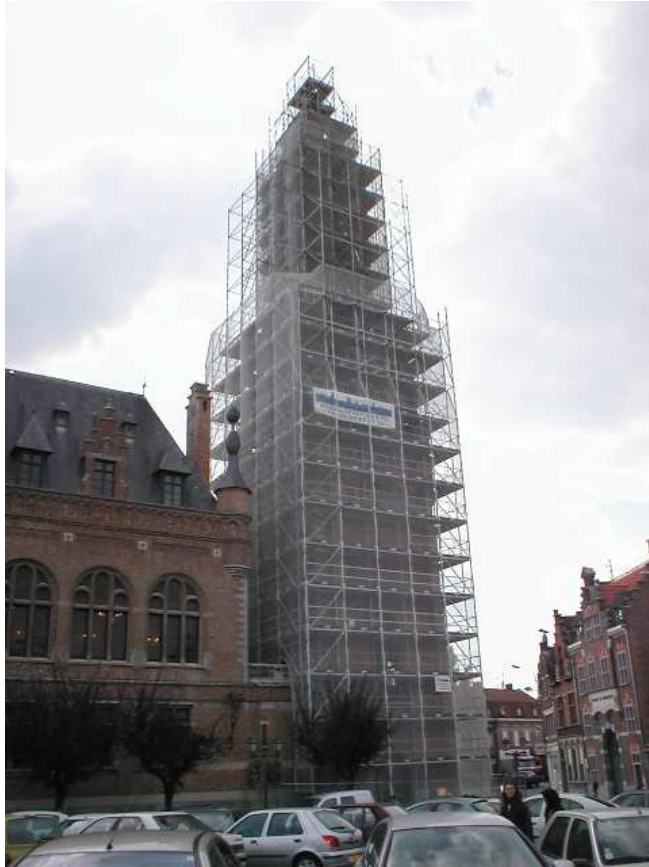
Figure 94 : Chantier de rénovation du beffroi, 2002 (photographie personnelle).
