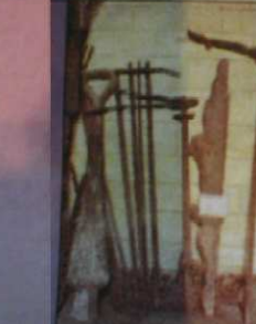
Ce n'est plus le gardien qui doit aujourd'hui dans le haut du beffroi mais seulement quelques attributs de l'ancienne cloche : son battant (la gauche) et le mouzon (pièce de bois qui la soutenait).
