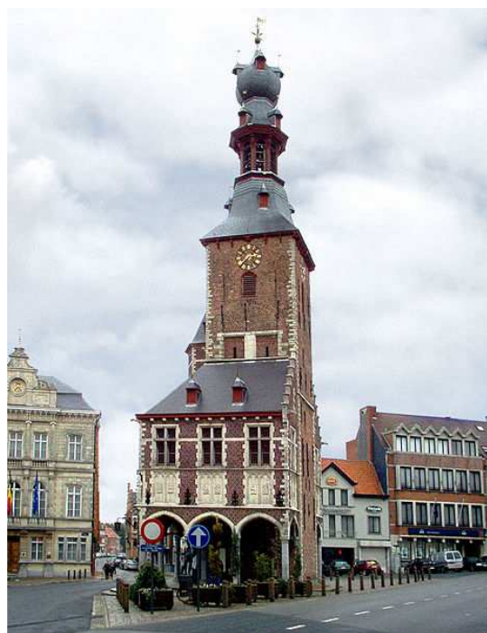
Figure 38 : Le beffroi de Tiel - source : Wikipédia.
