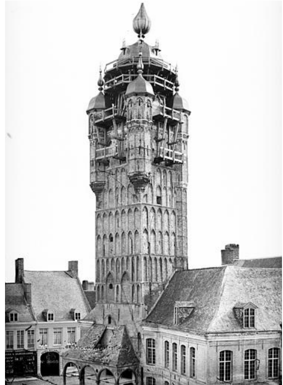
Figure 83 : Beffroi en cours de restauration - remis par M. Robert le 24 février 1893 - Ministère de la Culture (France), Médiathèque de l'architecture et du patrimoine (archives photographiques)
