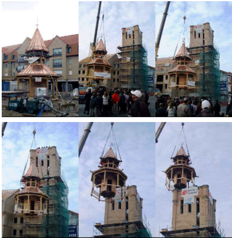
Figure 170 : Edification du beffroi de Saint Pol.
