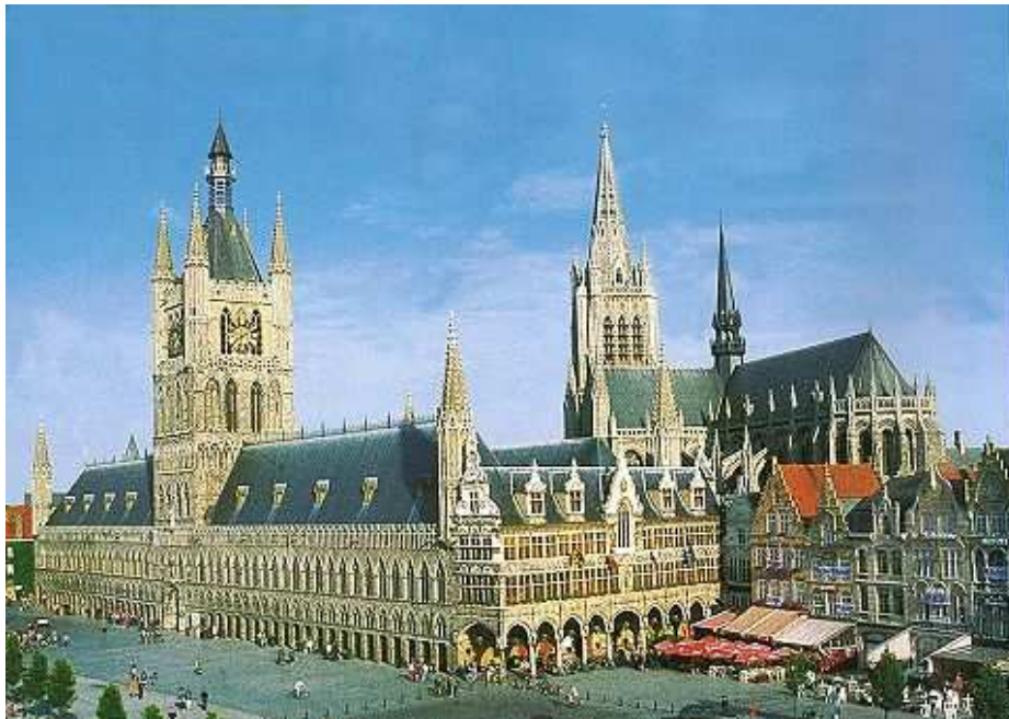
Figure 43 : Vue d'ensemble du beffroi d'Ypres.
