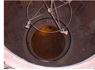
Figure 231 : Vue du second étage
