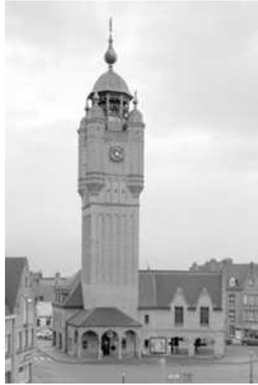
Figure 85 : Le beffroi, après sa reconstruction (1961)
