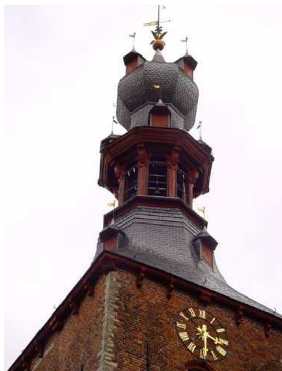
Figure 39 : détail du haut de la tour.
