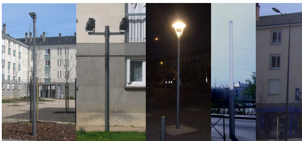
Figure 22 : Mobilier urbain d'éclairage après la rénovation
