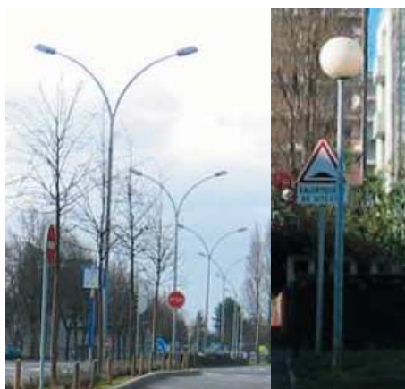
Figure 27 : Candélabres des quartiers Belles Portes et Grand Parc avant la rénovation
