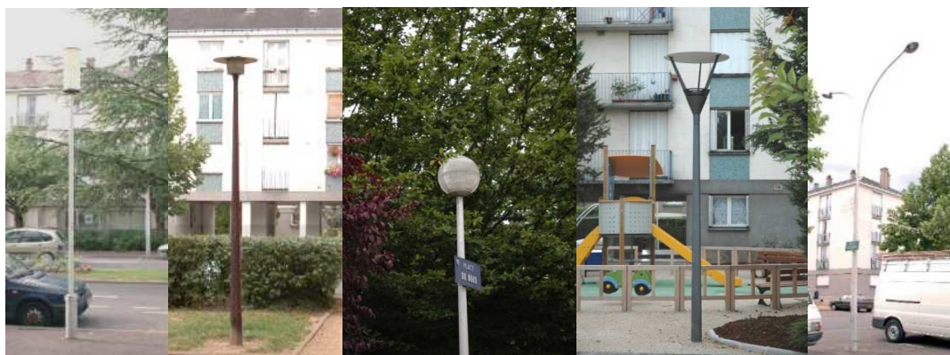
Figure 21 : Mobilier urbain d'éclairage avant la rénovation
